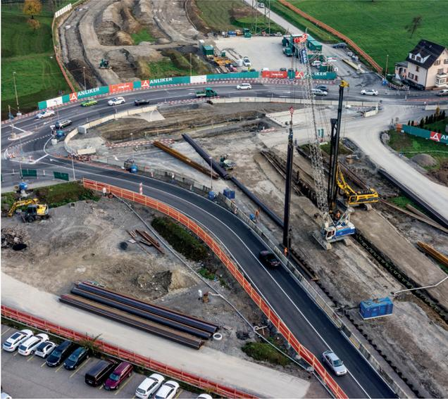
Im Bereich Neufeld und Südstrasse mussten die Spundwände bis in eine Tiefe von 20 Metern und darüber hinaus in den Boden einvibriert werden.
