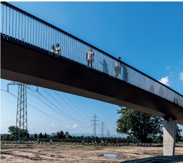
Die neue Fussgänger- und Velobrücke in Inwil. Die Stahlbrücke besteht aus drei Teilen, ist 66 Meter lang und wiegt 173 Tonnen.
