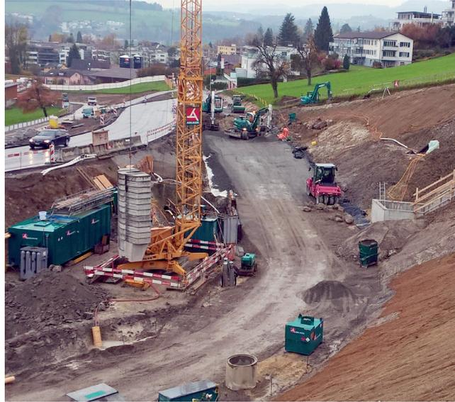
Beim Mittelbach-Durchlass im Margel ist der erste Teil gebaut. Die Strasse wird abgesenkt, bevor der Abzweiger Richtung Tunnel gebaut werden kann.
