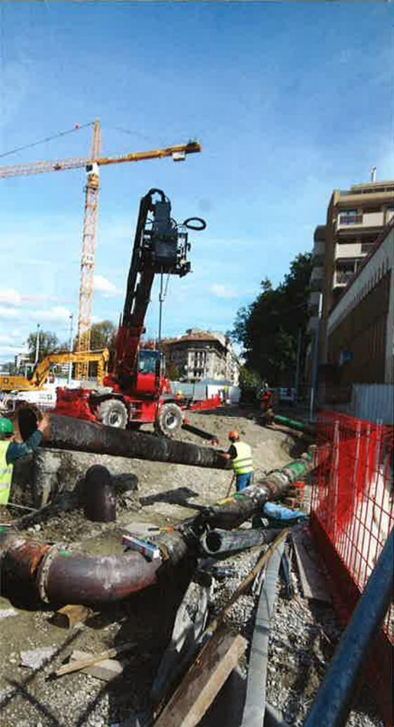
Les travaux nécessitent un énorme travail de déviation et d'adaptation des réseaux souterrains.
