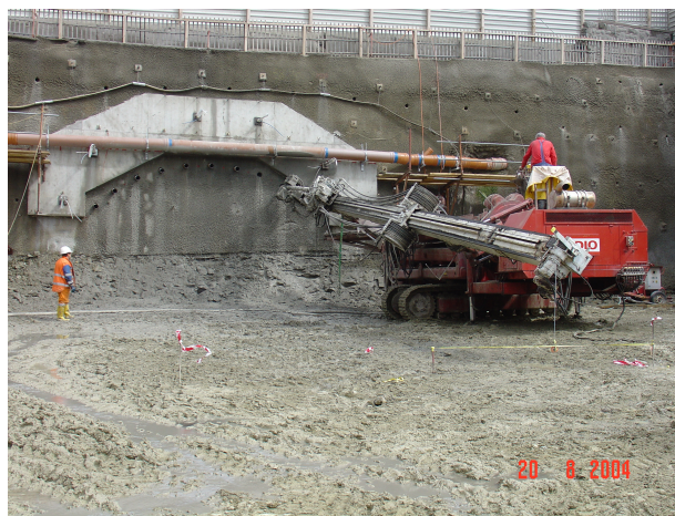
Image 2 : Portail CHUV du tunnel des Falaises
