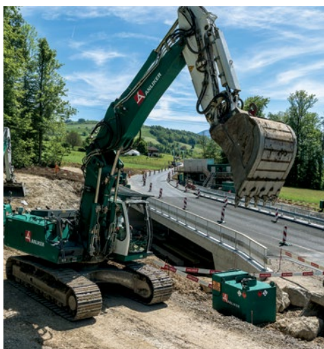
Die Bagger sind im Margel weiter im Einsatz.
