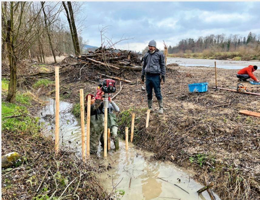
Fig. 9a Der Bau von BDA erfordert i. d. R. nur einfache Werkzeuge und Baumaterialien. Üblicherweise wird zuerst ein Grundgerüst aus Holzpfählen erstellt. Lage, Höhe, Breite und Verankerung der BDA sind auf die Projektanforderungen abzustimmen (vgl. Kap. «Planungsgrundsätze»).
