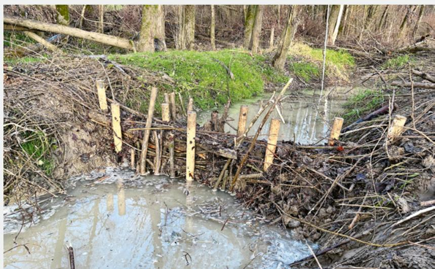
Fig. 6 BDA kurz nach der Erstellung, mit Wasserpegelanstieg um rund 10–15 cm. Der Pegelanstieg bewirkt einen Anstieg des Grundwassers (vgl. Stadium A, Fig. 2). Seriell eingebaut, kann der Wasserrückhalt selbst in kleinen Bächen stark vergrössert werden. (©S. Minnig)
