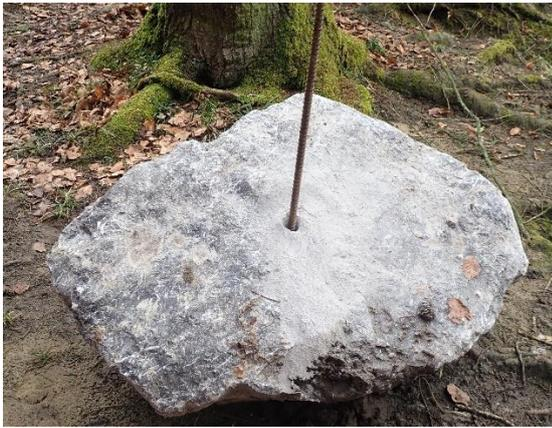
Abbildung 49: Felsanker mit Ankerstange in Blockstein
