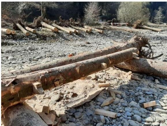
Abbildung 51: Holzverbindung mit Robinen-Kantholz. Der Einschnitt im Baumstamm fällt relativ gross aus und schwächt die Dauerhaftigkeit der Struktur.
