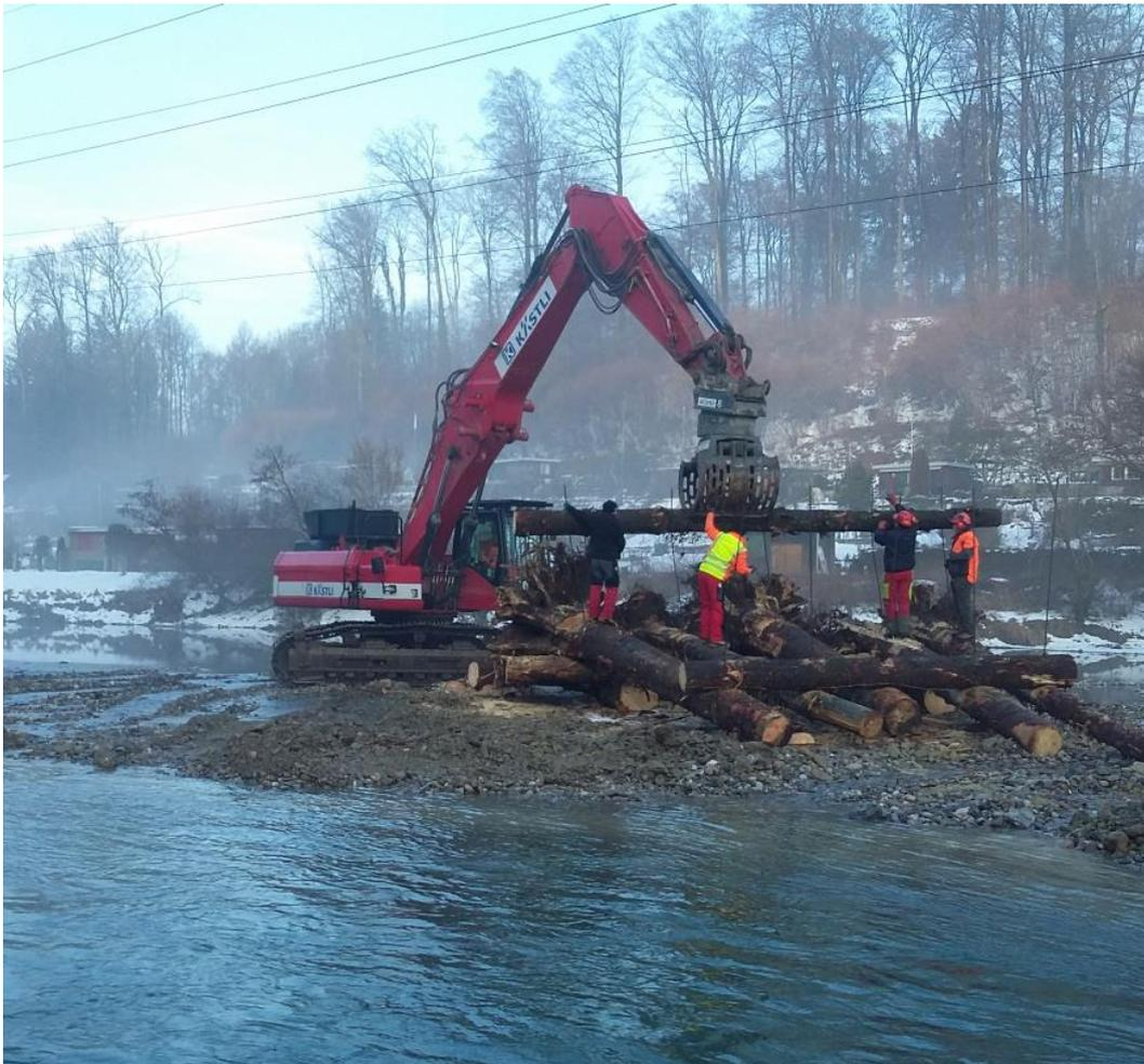
Abbildung 19: Landseitiger Vorbau des Unterbaus einer Einbaugruppe / Segment für die Platzierung 2.5 m unter dem Wasserspiegel, stark angeströmt (Aare in Bern), siehe dazu auch Kastenbauweise in Anhang A.3.
