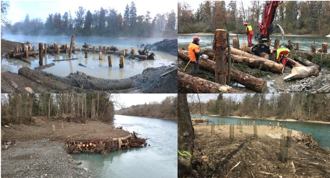
Abbildung 30: Einbauzustände und fertige ELJ-Buhnen an der Aare, Fahrhubel, Belp (Quelle: <https://www.aare.bve.be.ch>)
