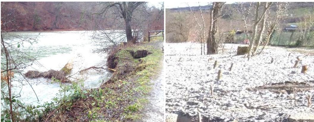
Abbildung 27 : Nach Hochwasser erodiertes Ufer (links) und neu erstellter ELJ-Uferverbau (rechts) an der Aare in Bern (Löchligut). Um eine Gefährdung von Schwimmenden und Booten zu verhindern (intensive Freizeitnutzung) wurden die oberen Lagen (Bandbreite Sommerwasserspiegel) ohne Wurzelteller ausgeführt (Reduktion Rauigkeit).
