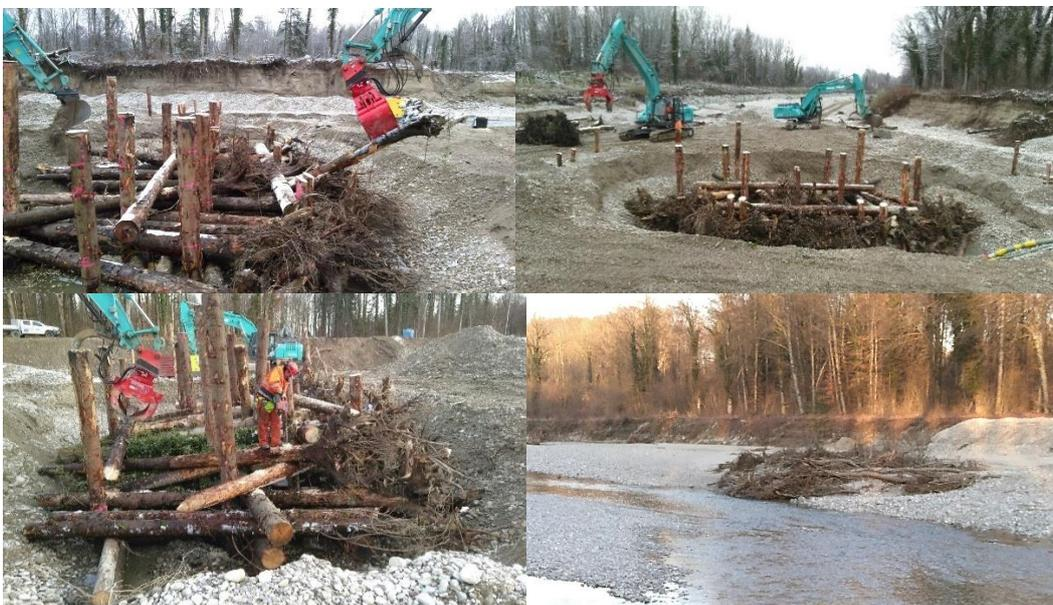
Abbildung 41 : Beispielbilder: Einbau Inselkopf-ELJs im lageweisen Verfahren an der Emme, Bätterkinden-Utzenstorf
