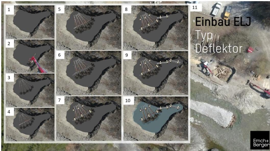
Abbildung 35 : Einbauschema Deflektor-ELJ (lageweiser Aufbau) mit verstärkter Ufereinbindung gegen Hinterspülung an der Sense, Ruchmühle BE. (Werdenberg, et al., 2020)
