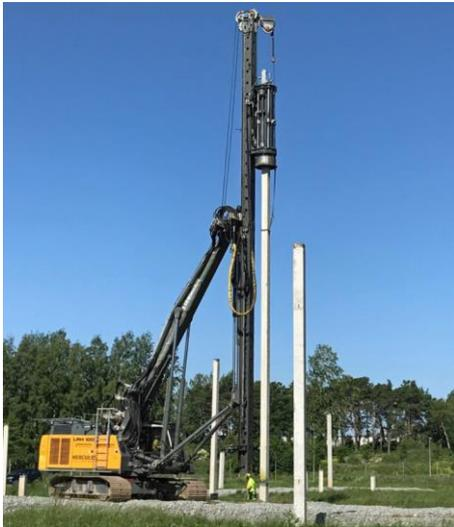
Abbildung 53: Rammgerät Hänge- und Schwingmäkler (Bildquelle: Liebherr-International AG)
