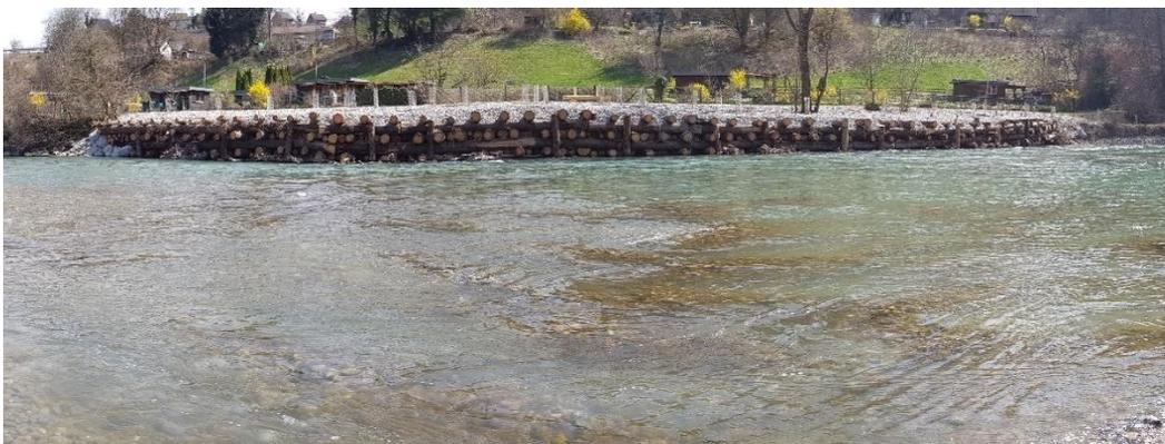
Abbildung 29 : Fertiggestellter ELJ-Uferverbau an der Aare in Bern (Löchligut) bei Niederwasser, mit reduzierter Rauigkeit in den oberen Lagen.
