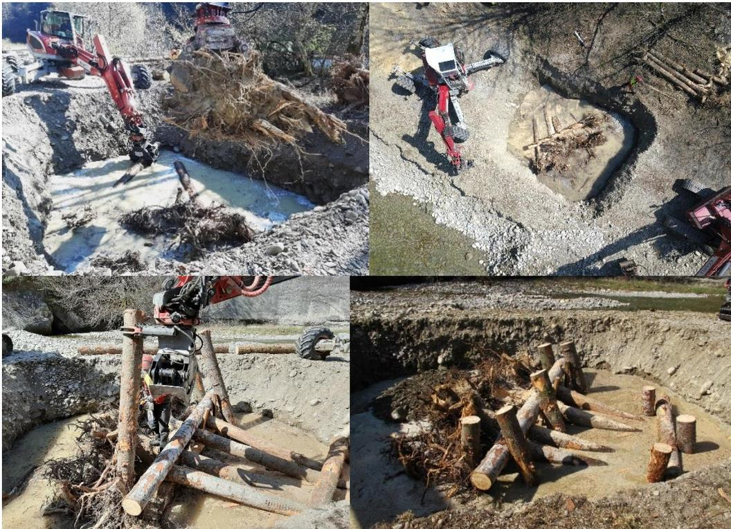
Abbildung 34: Einbau Deflektor-ELJ im lagenweisen Verfahren an der Sense, Ruchmühle BE
