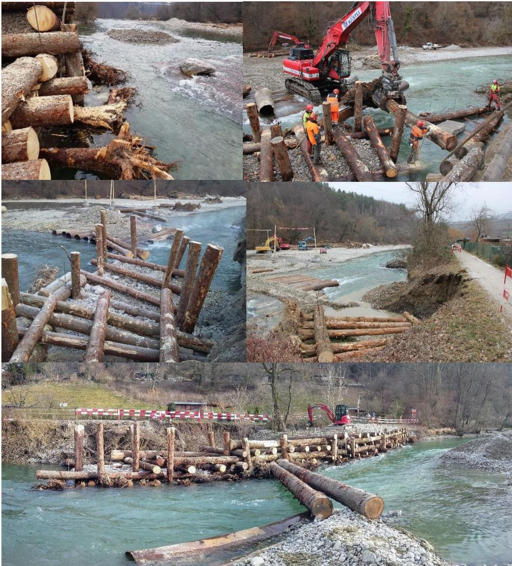
Abbildung 28 : Bauzustände ELJ-Uferverbau bei Niederwasser. Das Beispiel zeigt die Kastenbauweise, wie sie an der Aare in Bern (Löchligut) erstellt wurde und die reduzierte Rauigkeit in den oberen Lagen.
