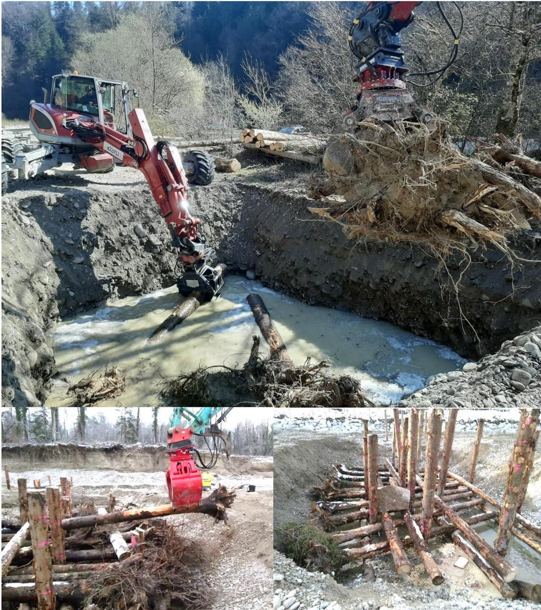
Abbildung 21 : Beispielbilder Einbau Wurzelstämme und Aufschichtung zu ELJ-Element.
