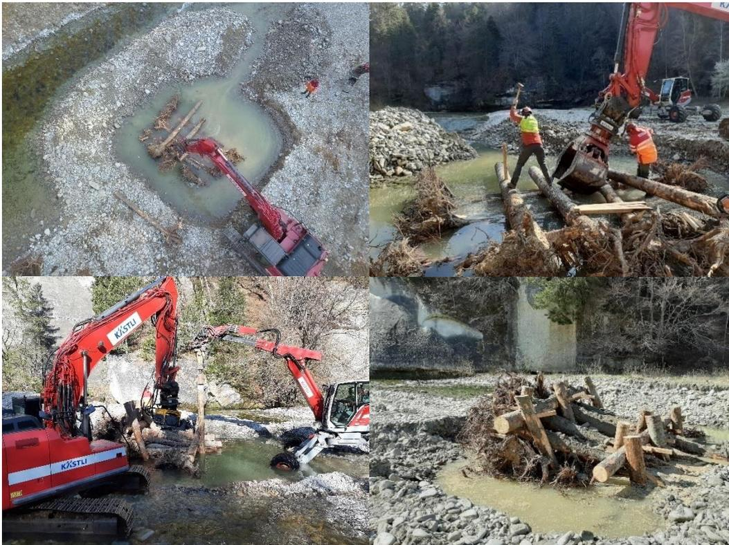
Abbildung 39 : Beispielbilder: Einbau Inselkopf-ELJs im lagenweisen Verfahren an der Sense, Ruchmühle BE
