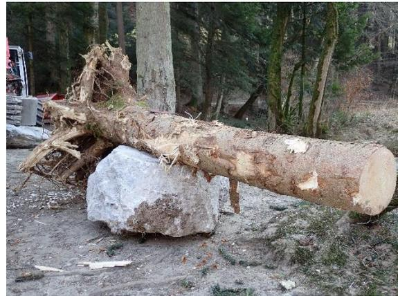
Abbildung 50: Befestigter Wurzelstamm auf Ankerstein
