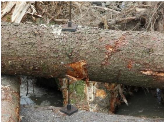
Abbildung 47: Dywidag Stabspannsystem mit Unterlagscheibe und Mutter
