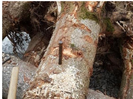
Abbildung 48: Armierungseisen als Nagelverbindung
