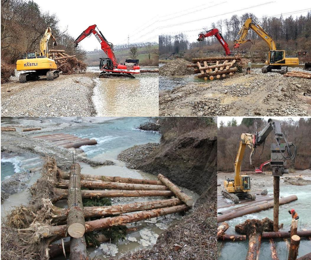
Abbildung 23 : Beispielbilder Transport und Einbau eines vorgefertigten ELJ-Kastenelements.
