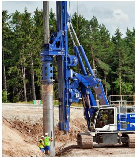
Abbildung 54: Bohrergerät mit Kellybohrverfahren. (Bildquelle: Liebherr-International AG)
